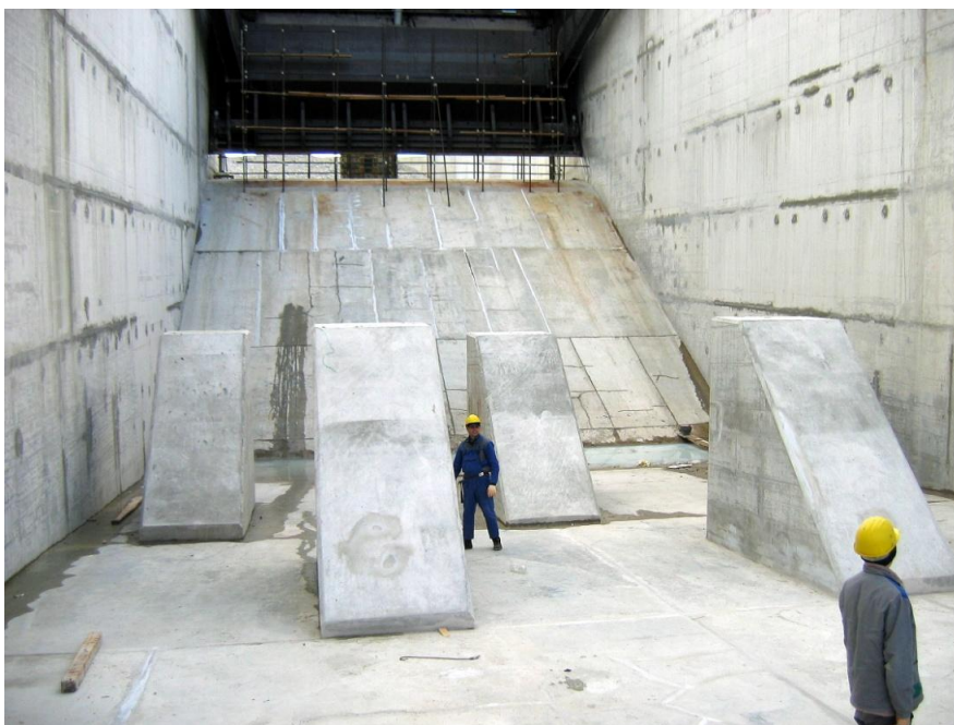
Slika 12: Prelivna polja HE Blanca v gradnji
